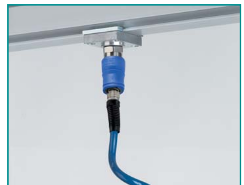
Fertig montierter Druckluftanschluß mit Sicherheitskupplung und Spiralschlauch.
